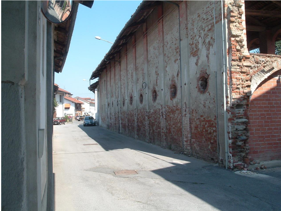
Intonaci degradati da ripristinare
