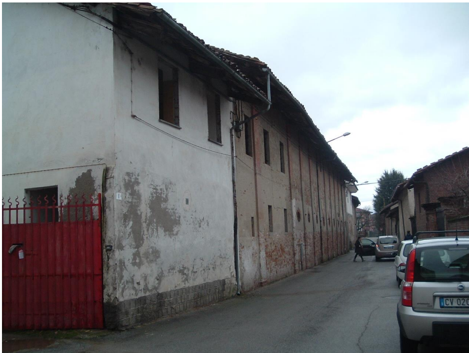
Intonaci degradati da ripristinare
