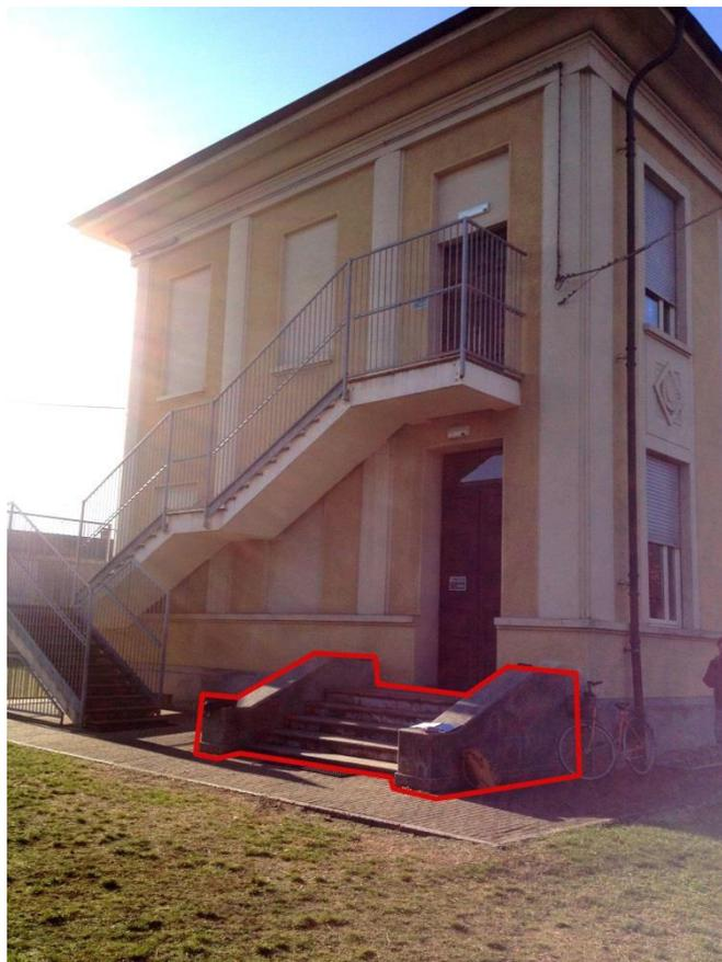
Sul prospetto sud, invece, per poter predisporre il nuovo ascensore, sarà demolita la rampa pedonale esistente e sarà necessario adattare l'apertura del piano primo in modo da permettere lo sbarco al piano.
