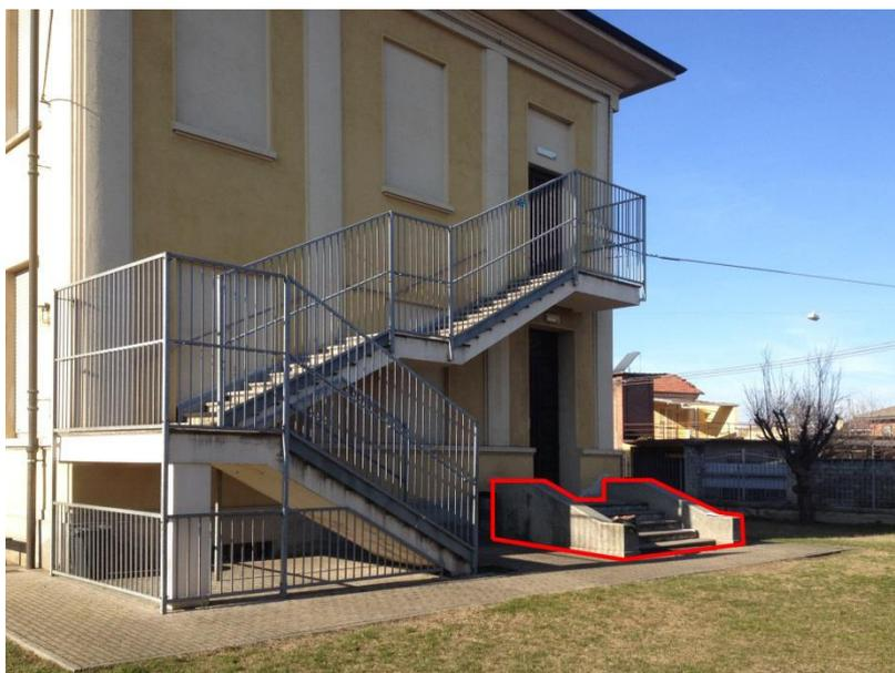
*Prospetto est - demolizione scala in cls*
