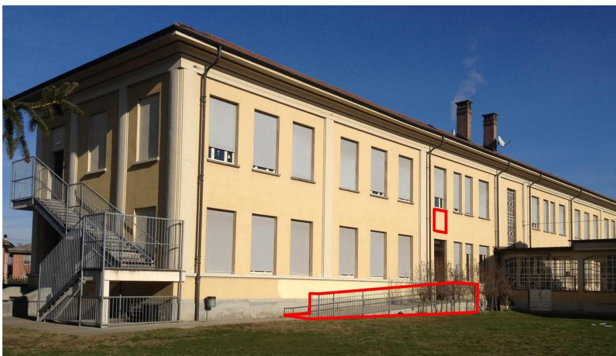
*Prospetto sud - demolizione di porzione della rampa pedonale e parapetto finestra*
