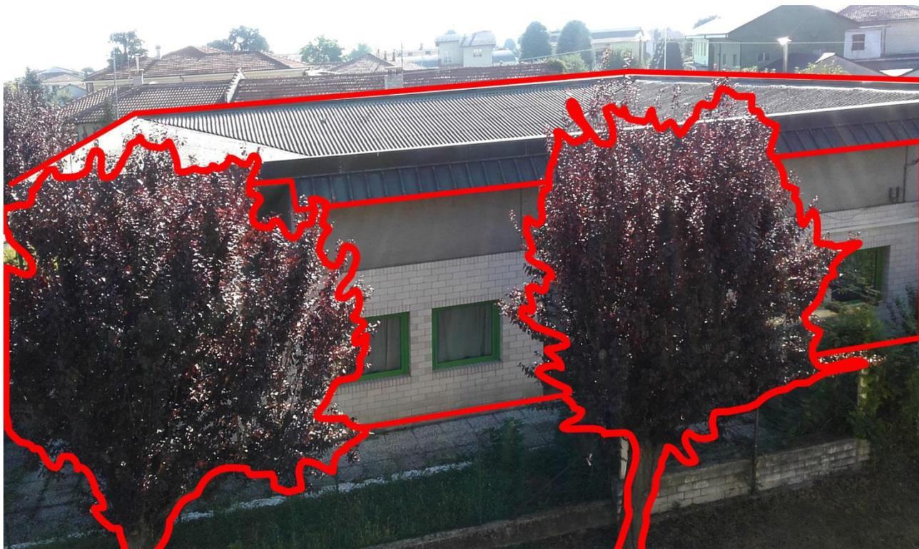
*Vista dalla scuola (prospetto ovest della Croce Rossa) – demolizione della copertura in amianto e rimozione delle alberature esistenti (4 alberi) che interferiscono con l'edificio ex novo della mensa*
