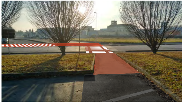
attraversamento su strada Provinciale SP1
